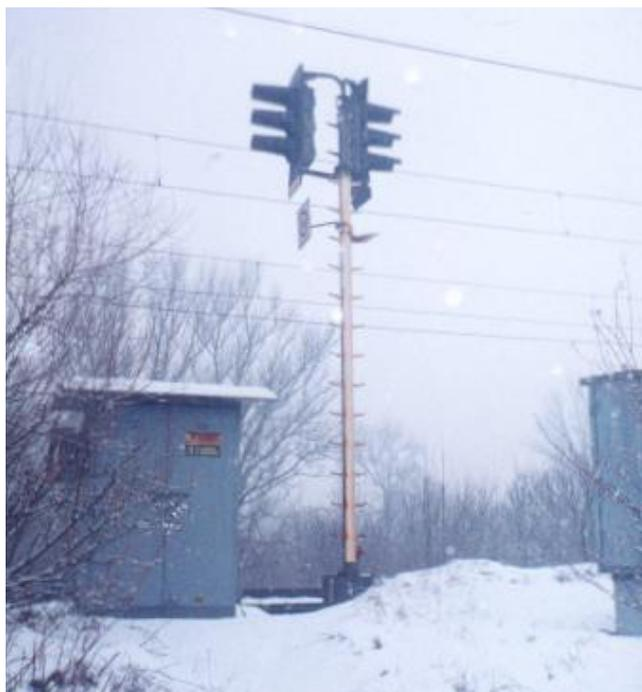
**Рис. 8.** Совмещенные блок-сигналы на двухпутном перегоне Жилина — Врутки в Словакии
