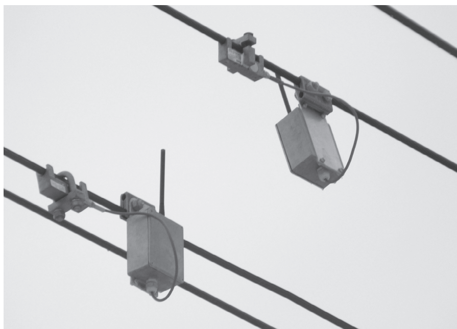
Рис. 5. Диагностические устройства на анкерном участке вблизи станции Любань в процессе эксплуатации
