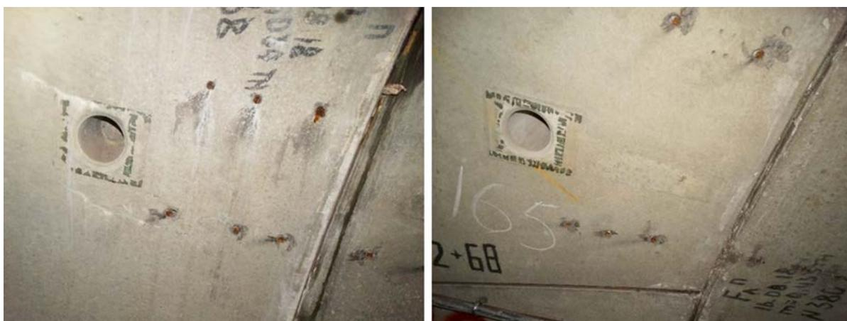
**Рис. 7.** Сколы бетона в местах установки болтов фиксации пластины
