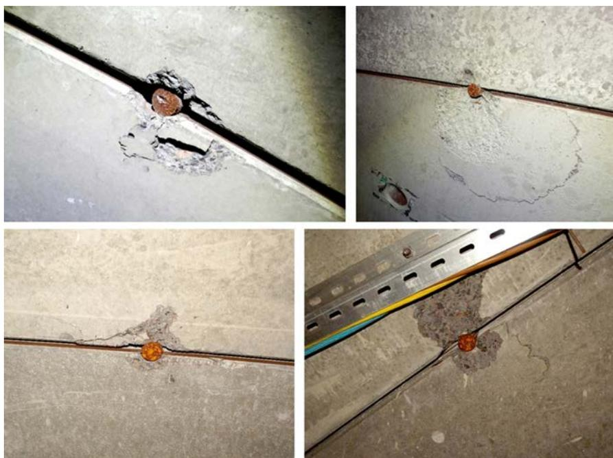
**Рис. 4.** Разрушение бетона в местах концентрации напряжений в стыке
