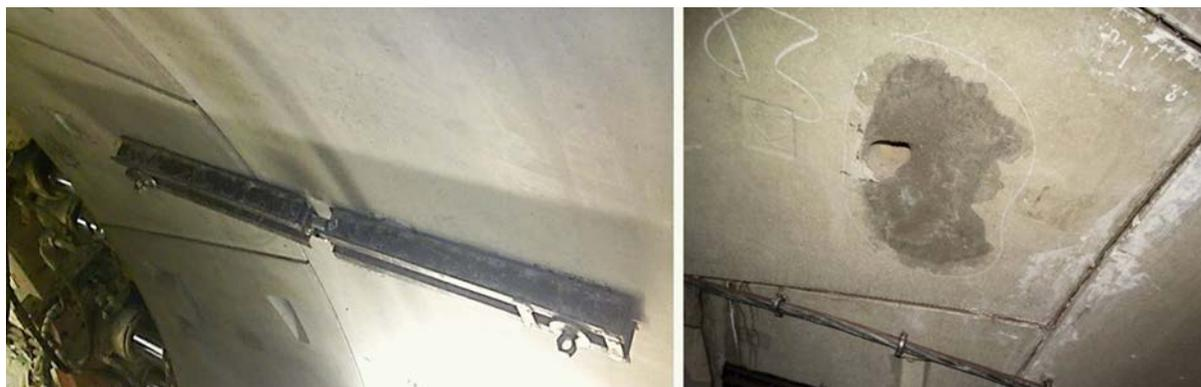
**Рис. 6.** Вид струбцины и разрушение бетона в местах концентрации напряжений у тампонажного отверстия
