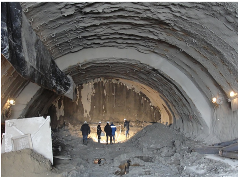
Рис. 4. Проходка и крепление калотты автодорожного тоннеля № 5 Дублера Курортного проспекта г. Сочи (фото: Е. А. Ермнина)
