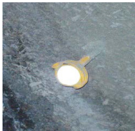
Рис. 2. Геодезическая марка, закрепленная в набрызг-бетоне
