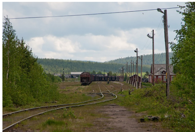
Рис. 3. Вид на станцию Алакуртти с восточной горловины
