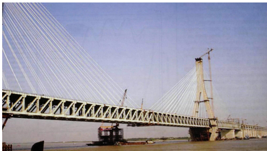
Рис. 6. Общий вид моста Тяньсинджоу во время строительства
