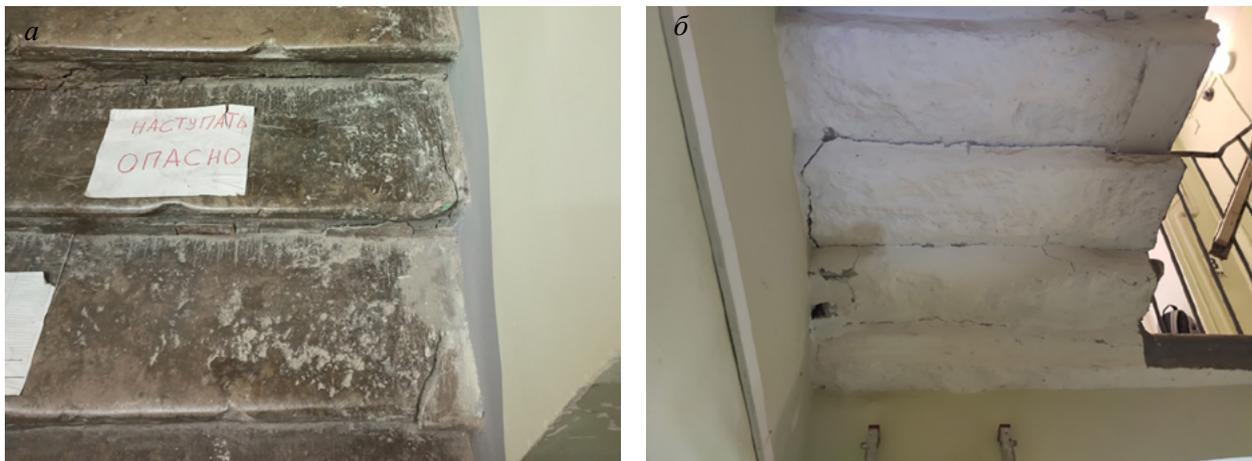
**Рис. 14.** Излом двух нижних ступеней марша от локальной перегрузки в Здании театрального декорационного зала и экипажного заведения, Б. Подъяческая, д. 20:
