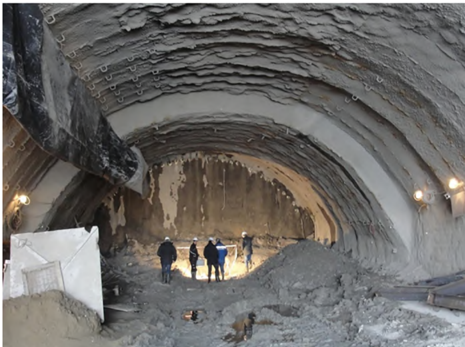
Рис. 4. Проходка и крепление калотты автодорожного тоннеля № 5 Дублера Курортного проспекта г. Сочи (фото: Е. А. Ермолина)
