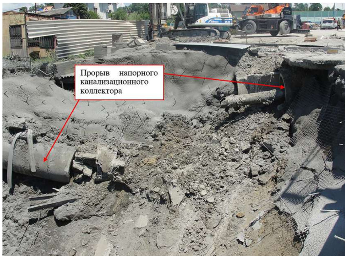
Рис. 8. Воронка обрушения на северном портале автодорожного тоннеля № 2 Дублера Курортного проспекта в г. Сочи, обусловленная прорывом напорного канализационного коллектора (фото: Е. А. Ермолина)
