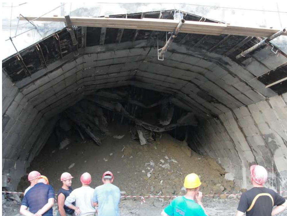
Рис. 7. Обрушение забоя при строительстве автодорожного тоннеля № 2 Дублера Курортного проспекта в г. Сочи (фото: Е. А. Ермнина)
