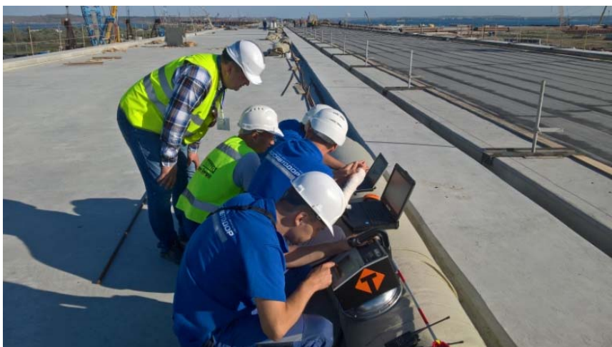
Рис. 4. Камеральная обработка результатов измерений ровности копирной струны
