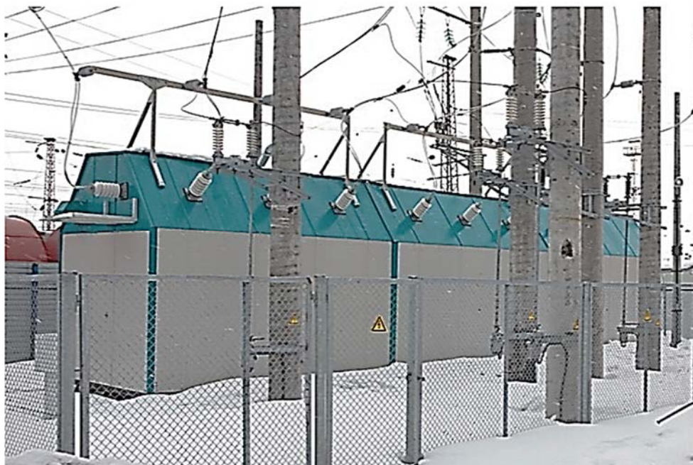
Рис. 5. Пункт группировки модульного типа ПГ-М-3,3/27,5
